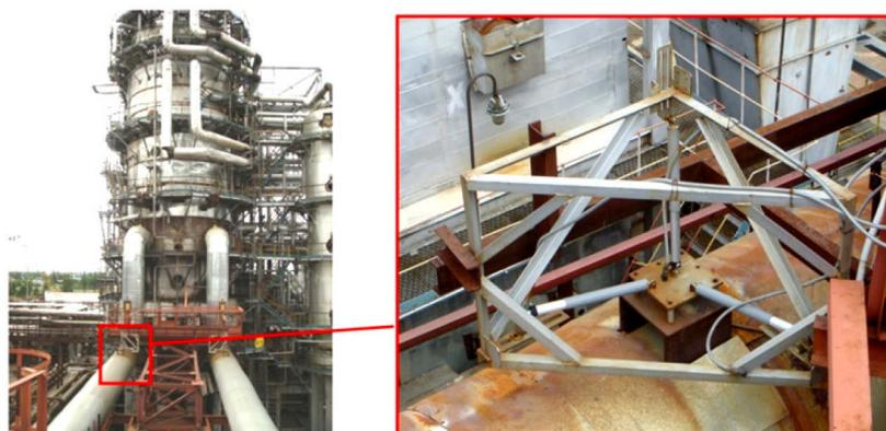
**Рис. 7.** Пространственная ориентация датчиков перемещений в точке контроля
