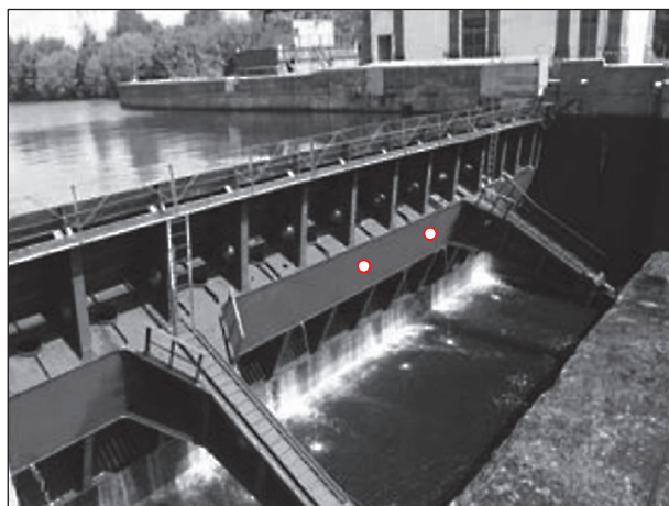
Рис. 8. Конструкция несущей части затвора
