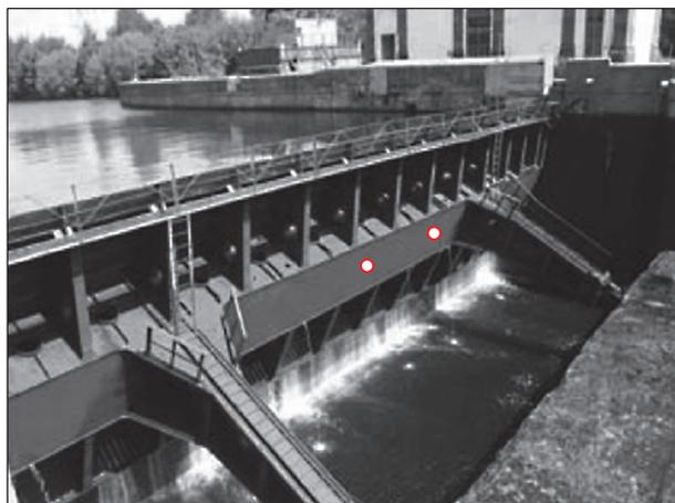
Рис. 8. Конструкция несущей части затвора
